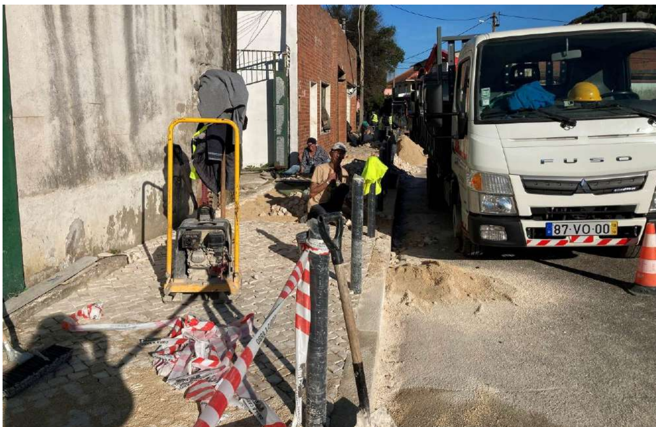
Estado geral durante a intervenção - poente/nascente
