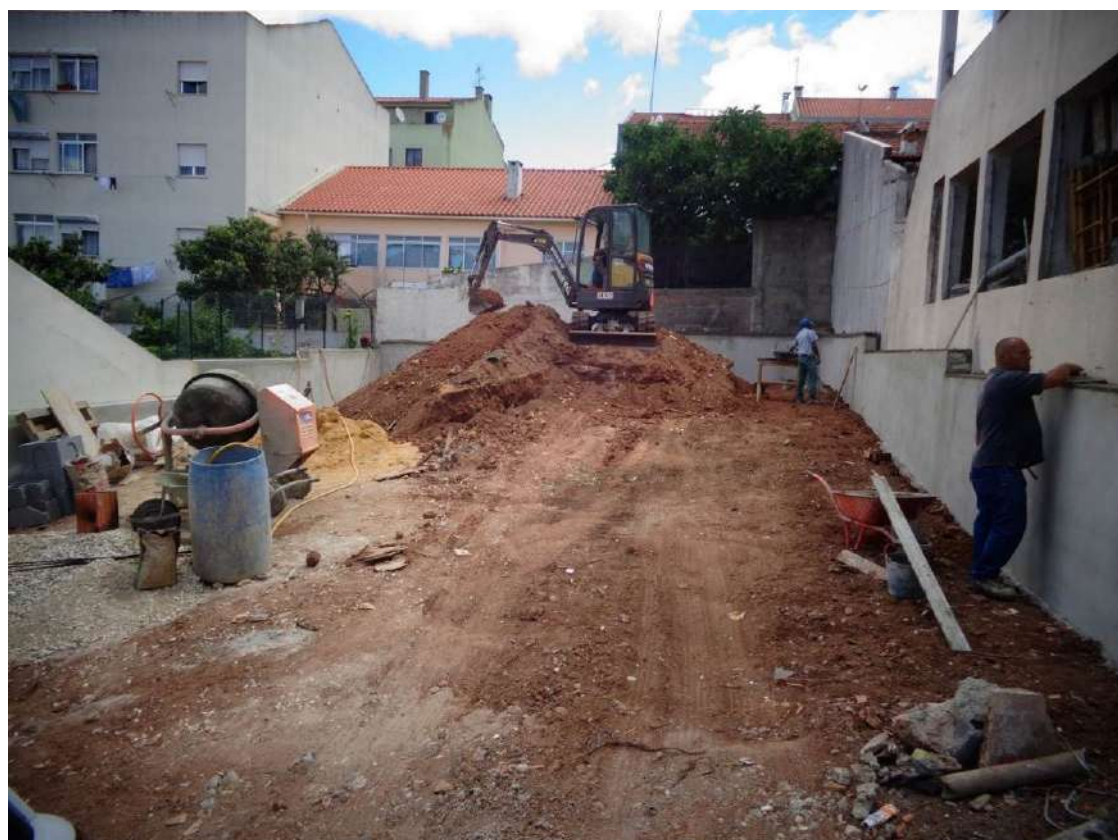
Local durante a intervenção
