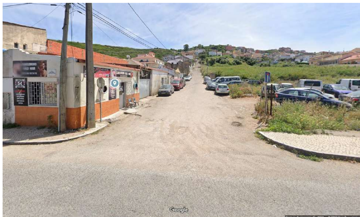
Estado geral antes da intervenção
