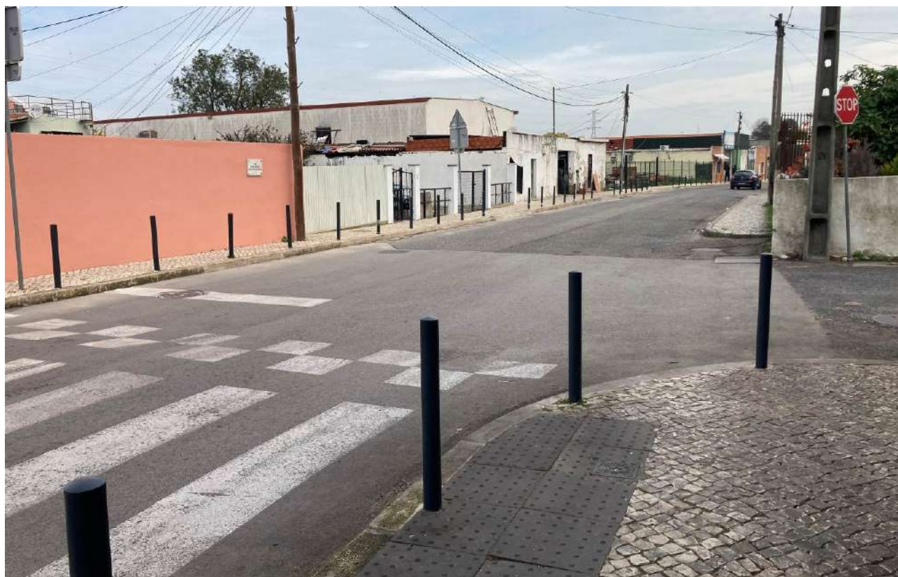
Estado geral após intervenção - poente/nascente
