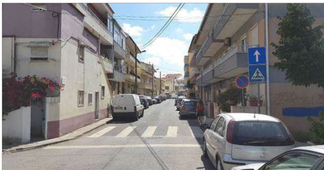
Estado geral antes da intervenção - nascente/poente
