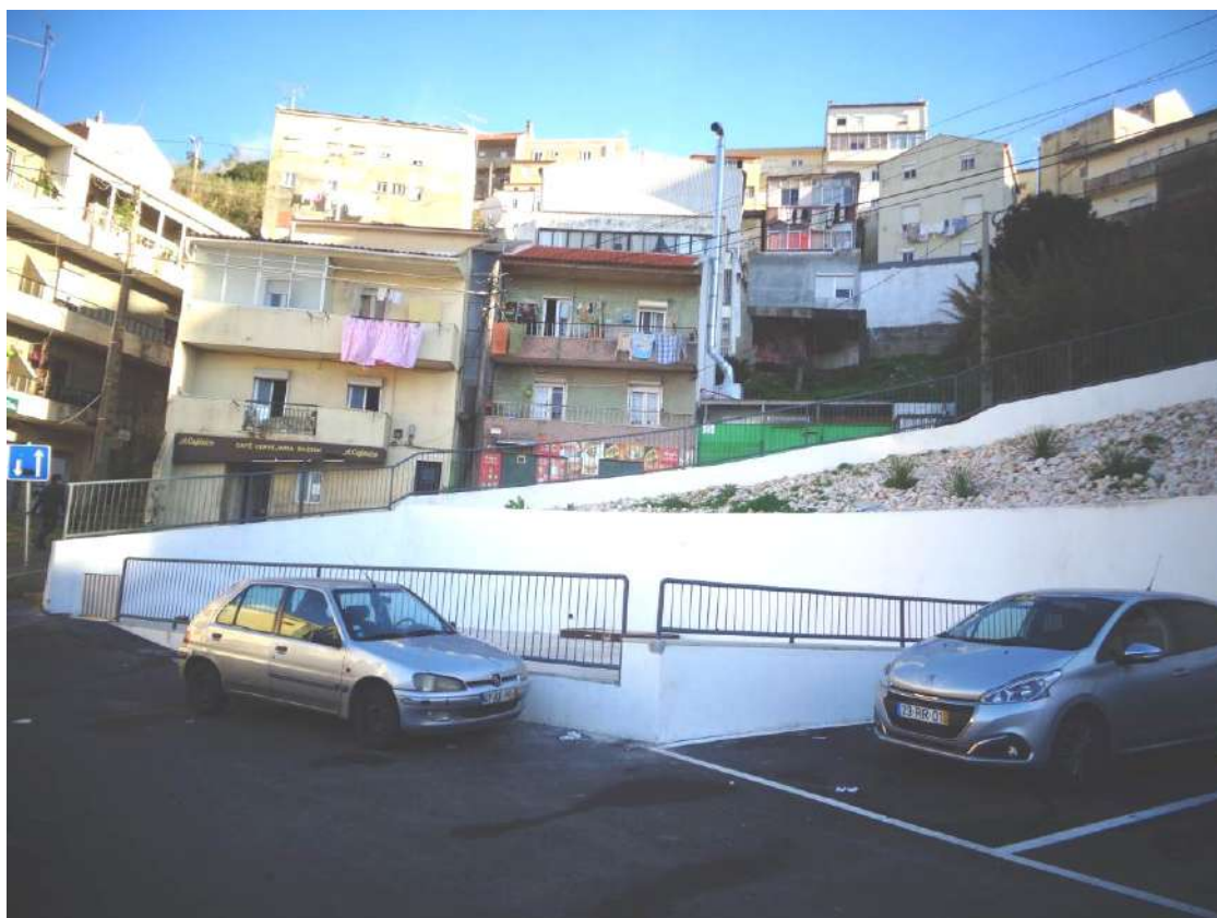
(aspeto do local posterior à intervenção)
