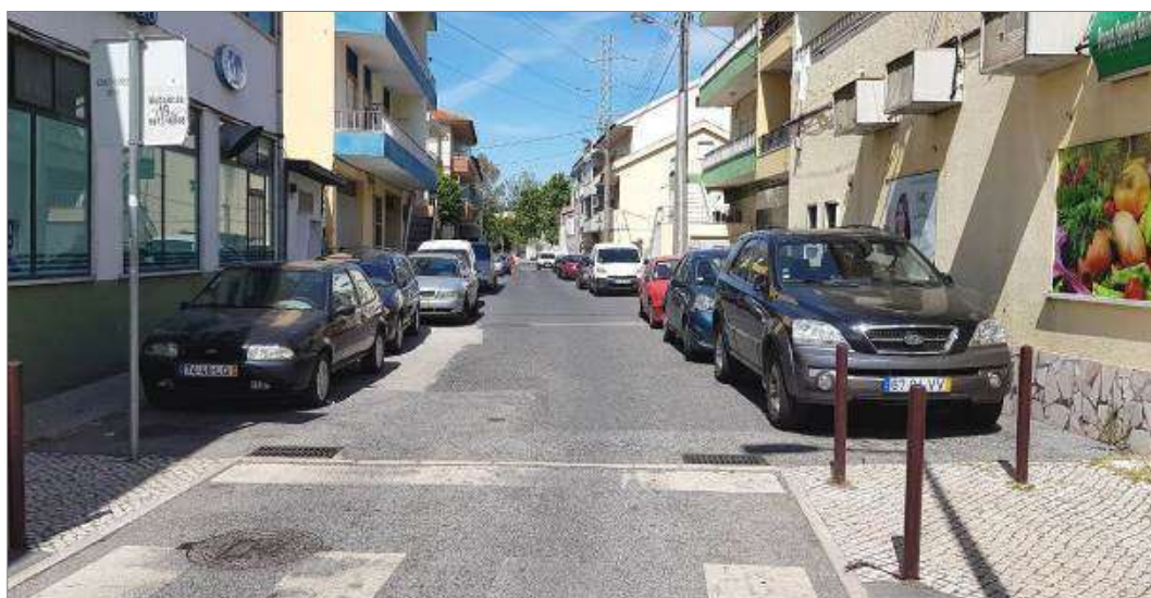
Estado geral antes da intervenção - poente/nascente
