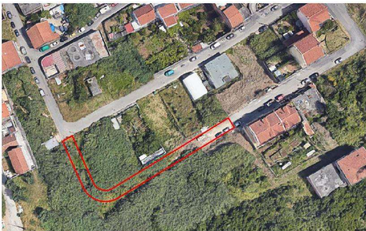
Local de intervenção
