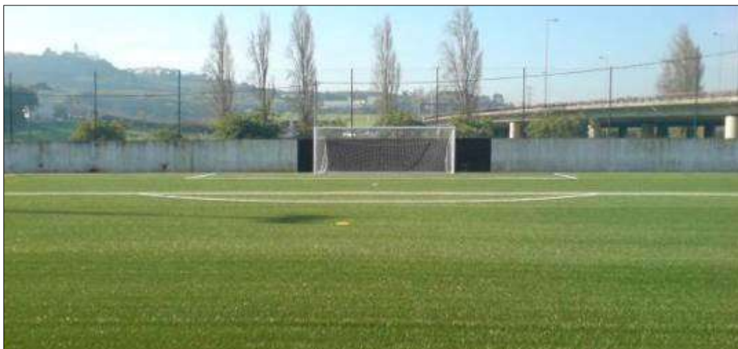
Após a intervenção
