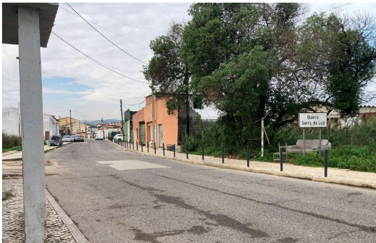
Estado geral após intervenção - nascente/poente
