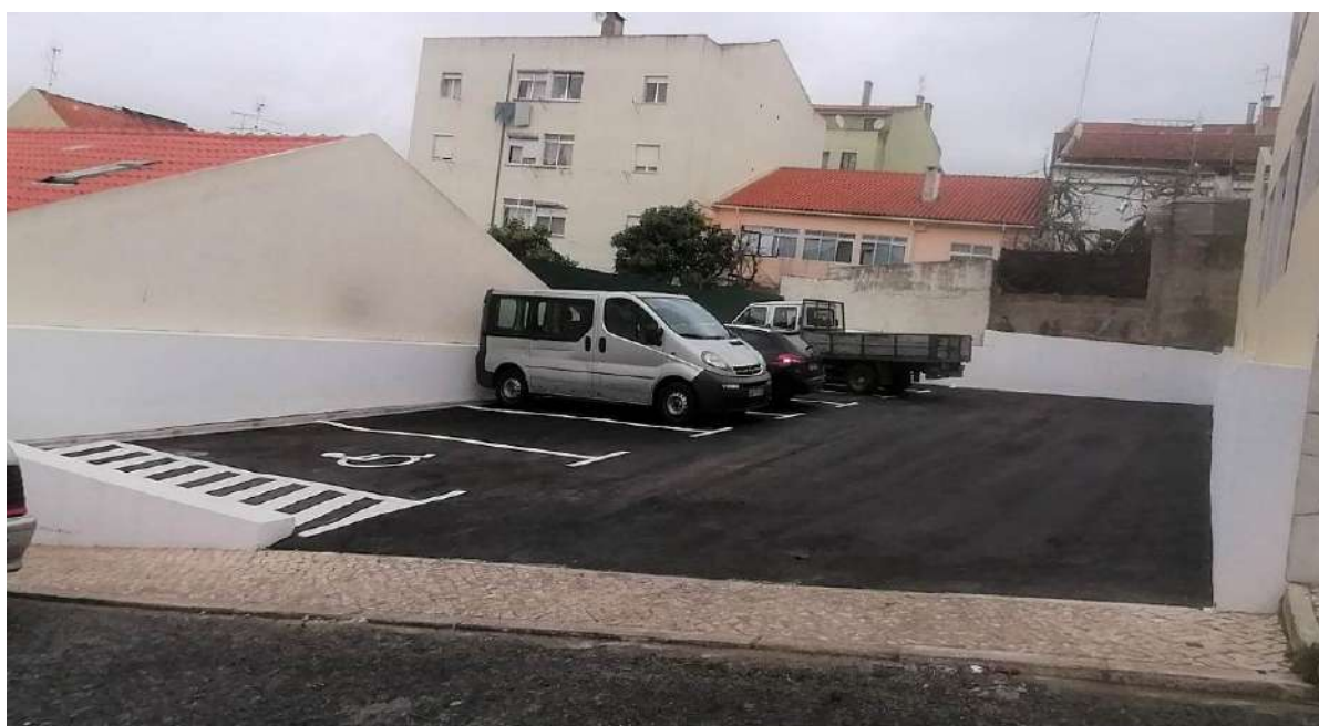
Local após a intervenção
