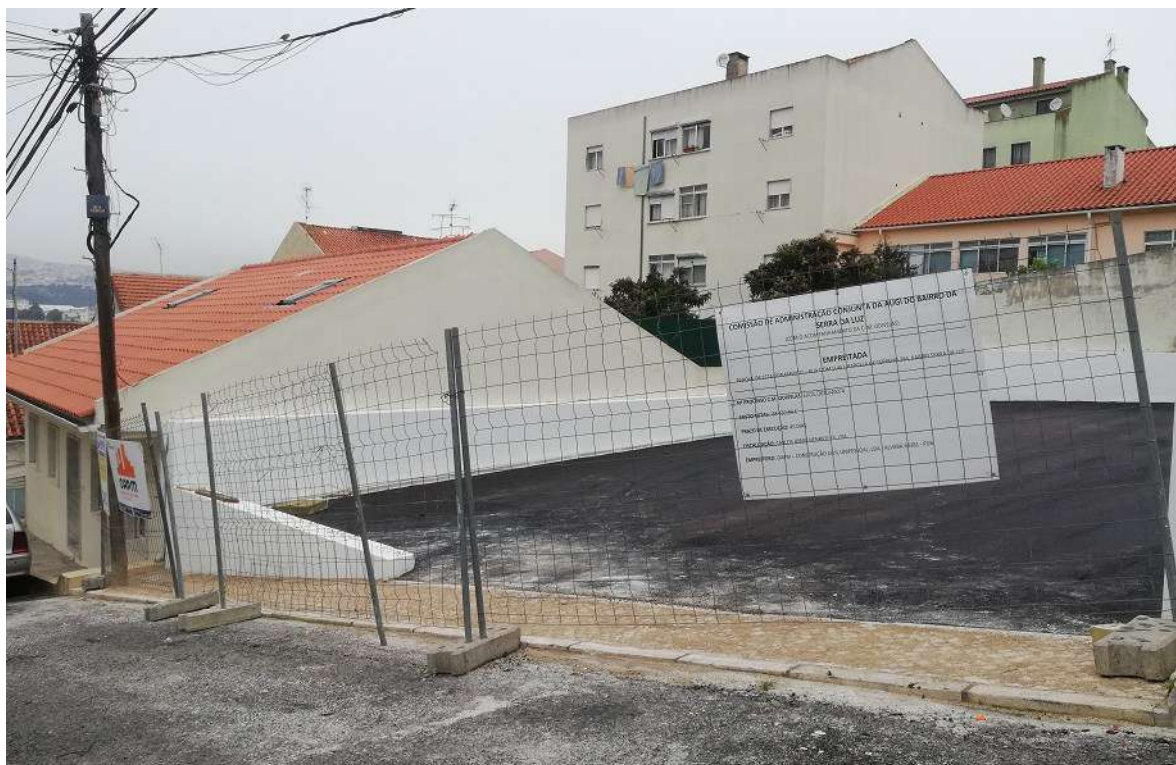
Local durante a intervenção
