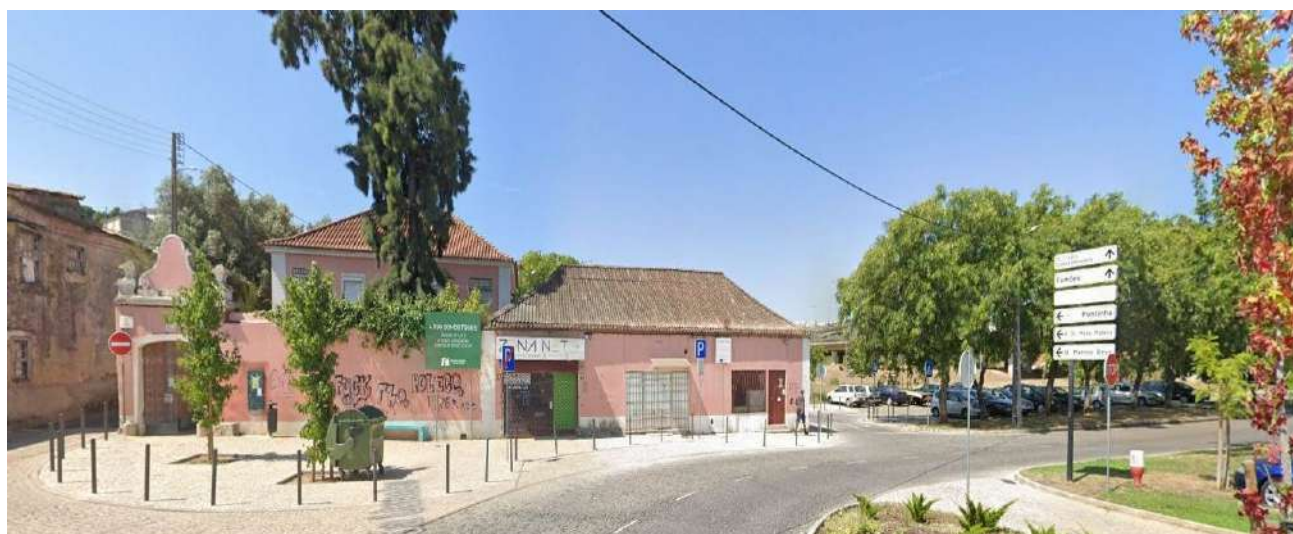
Local de intervenção
