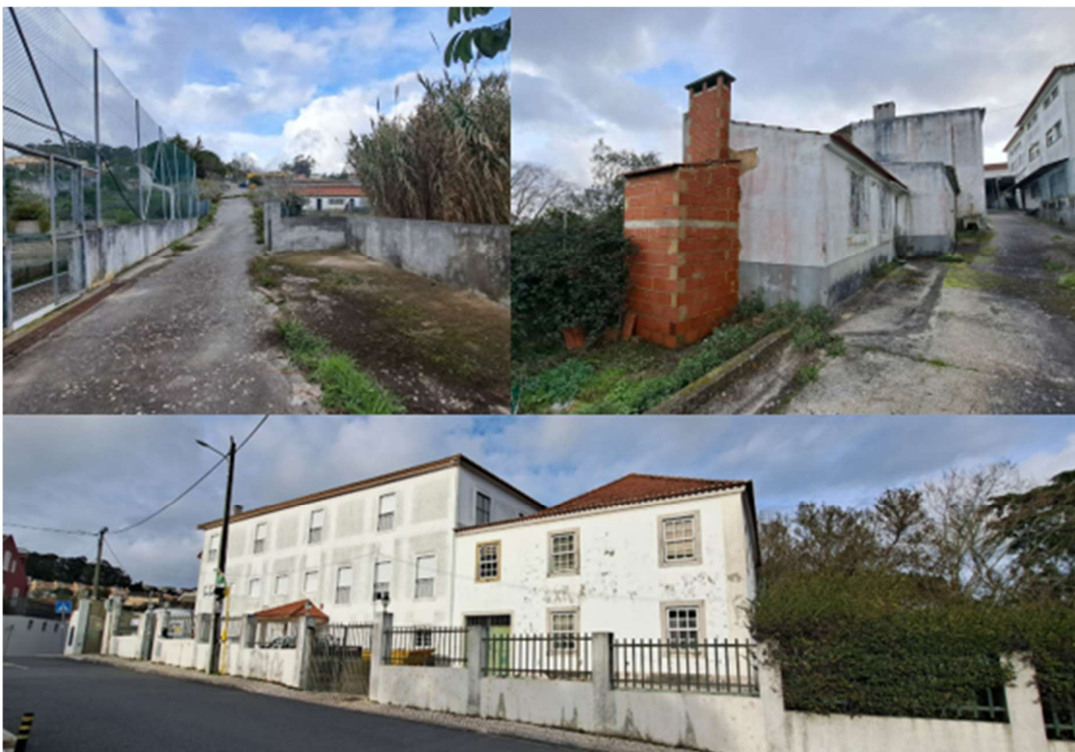
Figura 04: Em cima à esquerda: Imagem dos campos de jogo e da via de acesso interior asfaltada. E cima à direita: Imagem dos edifícios desqualificados que se pretendem erradicar. Em baixo: Imagem dos corpos mais antigos do conjunto orientados para o Largo Vieira Caldas.
