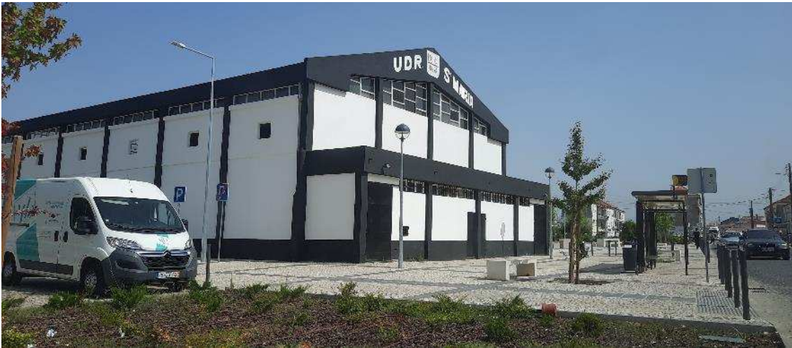
Figura 58. Instalações da UDR Santa Maria
